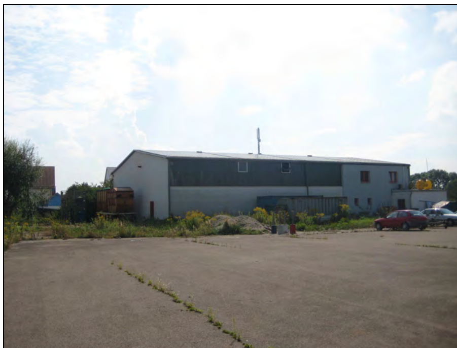
Abb. 1 Bestand altes Sägewerk – Blick von Norden
